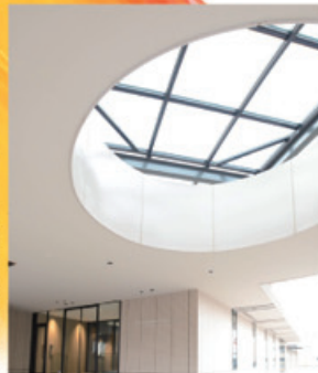
●2F入口付近
